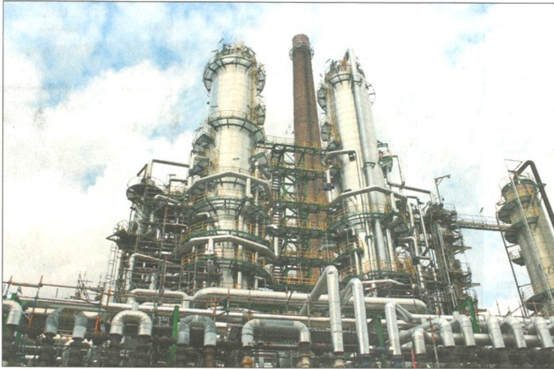
Die in Schwedt an der Oder vom Aglasterhausener Ingenieurbüro Schirk geplante und konstruierte Anlage. Foto: privat
